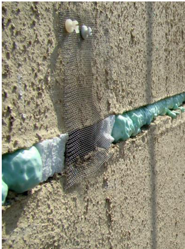
Obr. 3 Ukázka jednocestné uzávěry vletového otvoru připevněné pouze na horní straně otvoru
